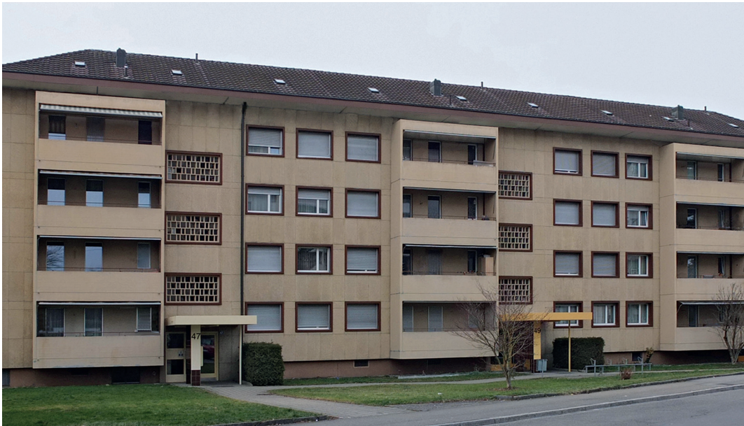
Gebäudefassaden der Siedlung Hirzenbach vor und nach der Erneuerung. Als nächstes folgt die Neugestaltung der Umgebung.
