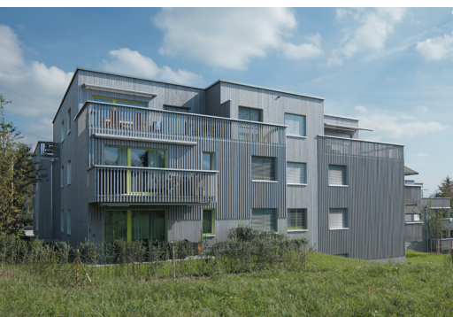
Die im Jahr 2018 fertiggestellte Siedlung Rebhaldenstrasse in Obfelden.
