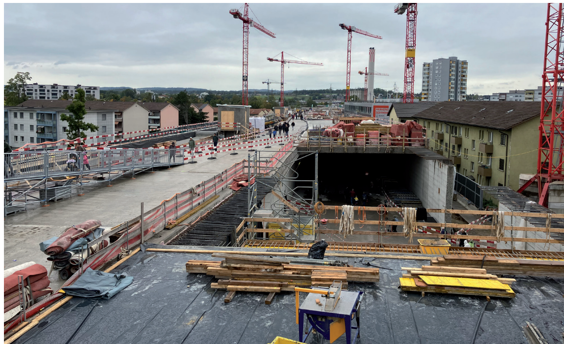
Baustellentag auf dem Ueberlandpark – im Hintergrund das Hochhaus der Siedlung Luegisland.
