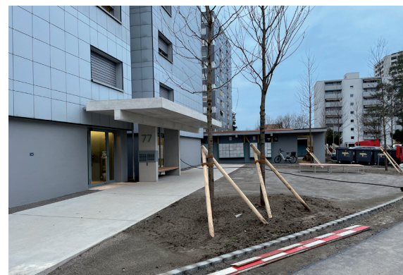
Der Eingangsbereich des Hochhauses an der Hirzenbachstrasse 77 während der Umgestaltungsphase.
