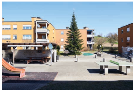
Siedlung Thalwiesen: Der Start der Instandsetzungsarbeiten erfolgt 2024.
